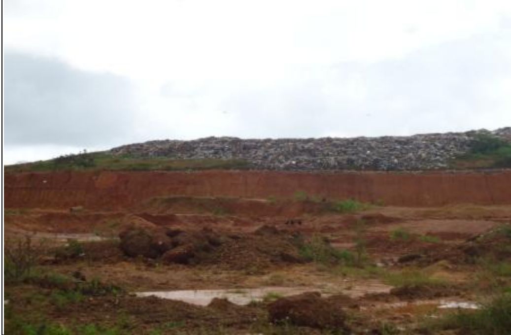
Foto 6: maciço de resíduos sem cobertura em março de 2013.
