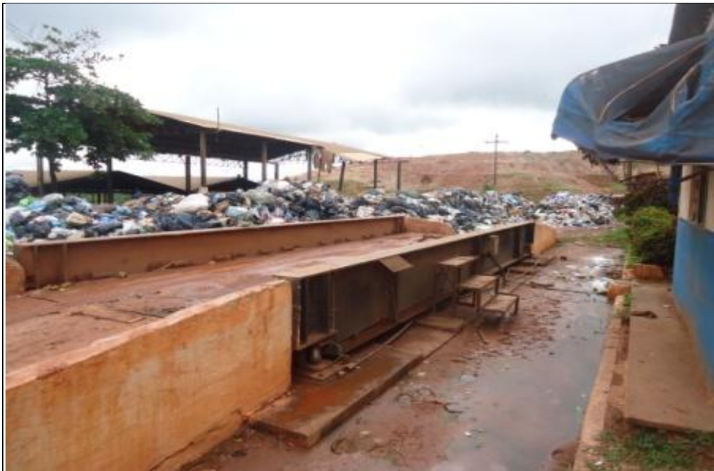
Foto 7: Disposição de resíduos em local inadequado, devido às fortes chuvas que impossibilitaram a subida e descarga dos caminhões na área de depósito em março de 2013.
