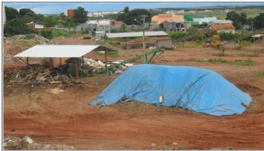
Foto 20: Estrutura da ATT – Produção de cavacos de madeira
