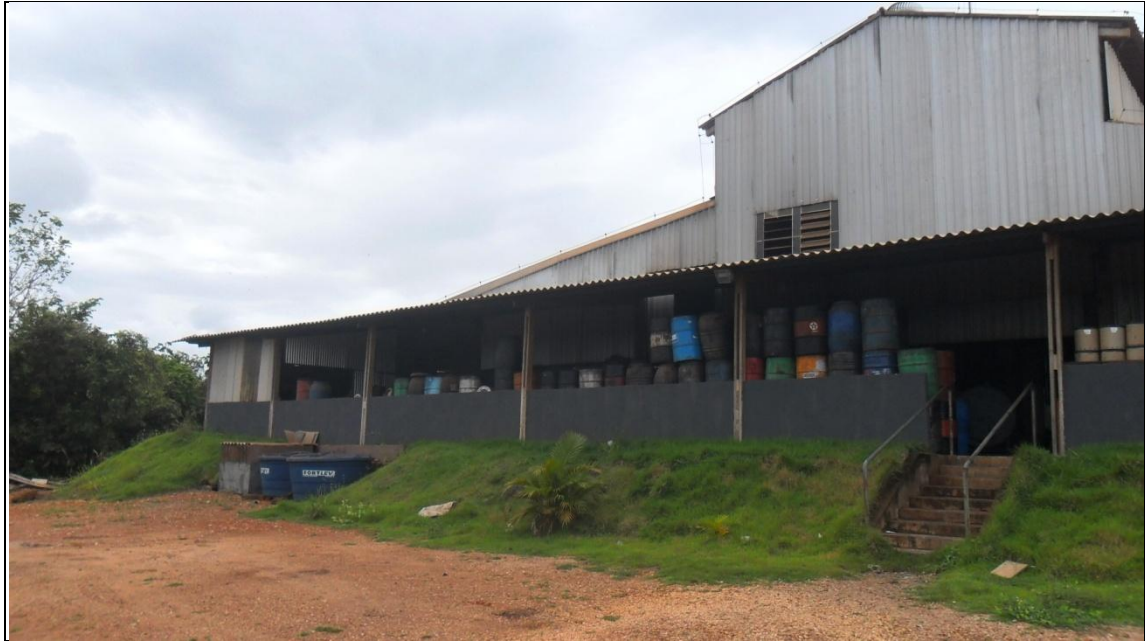
Foto 26: Vista dos fundos da WM Serviços Ambientais Ltda
