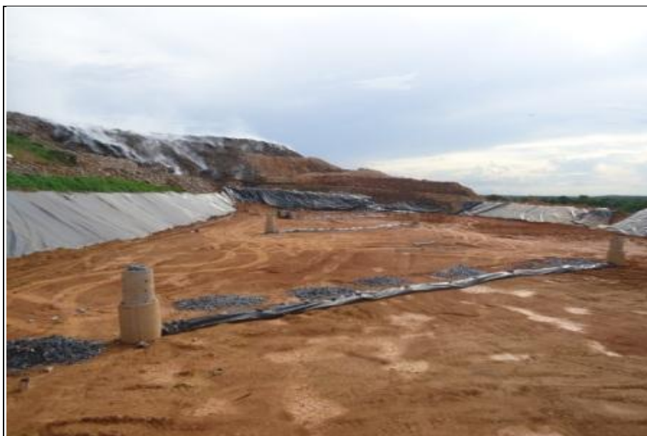
Foto 10: drenagem e impermeabilização da nova célula de resíduos – fevereiro 2013
