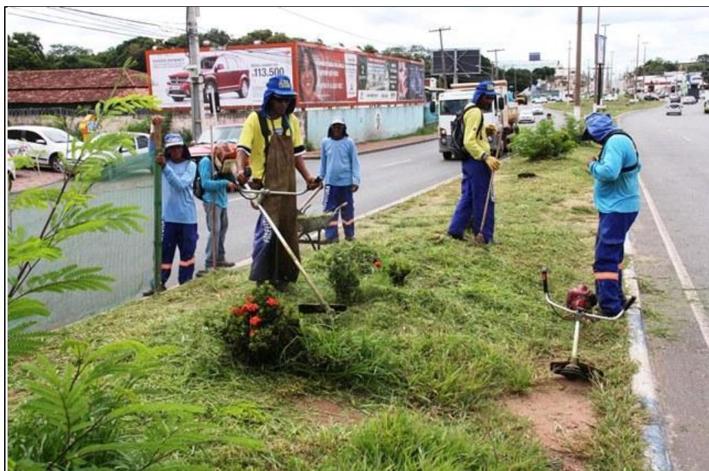
Foto 11: Roçada e limpeza de canteiro central de avenida
